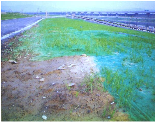
(A) 裸露地表鋪設防塵網
