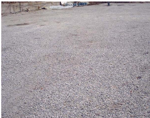
(E) 裸露地表鋪設粗級配
