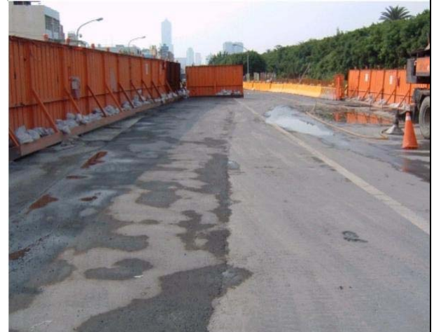
(D) 裸露地表鋪設瀝青混凝土
