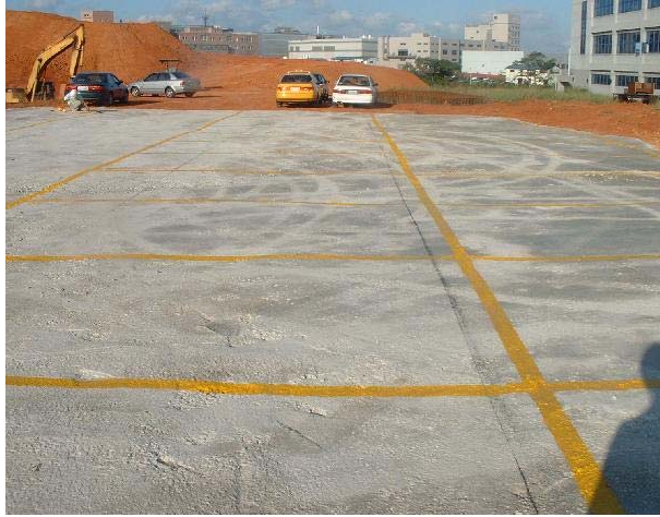
(C) 裸露地表鋪設混凝土
