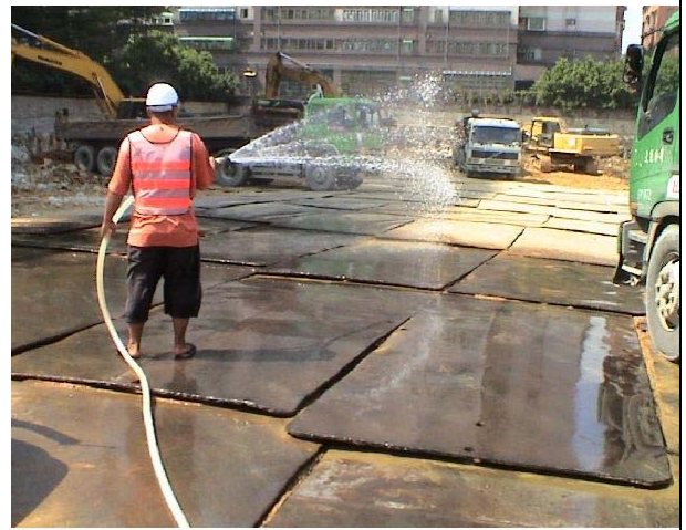
(B) 裸露地表鋪設鋼板
