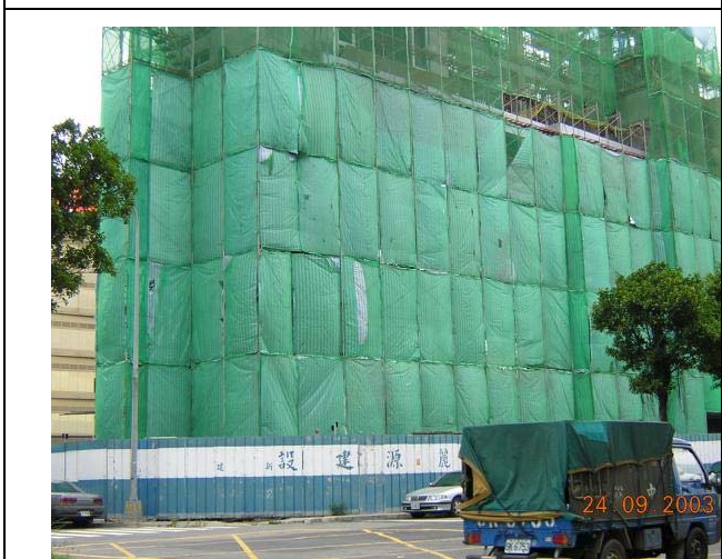
(C) RC 結構體設置防塵布
