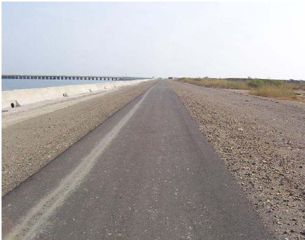
(C) 車行路徑鋪設瀝青混凝土
