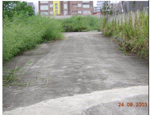
(B) 車行路徑鋪設混凝土
