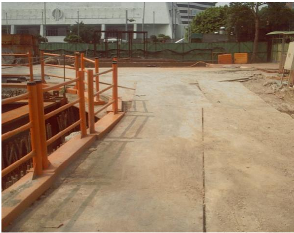
(A) 車行路徑覆蓋鋼板
