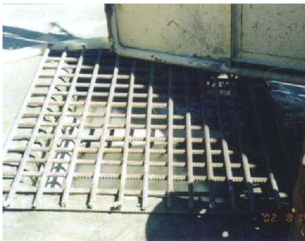
(G) 洗車廢水收集設施(一)
