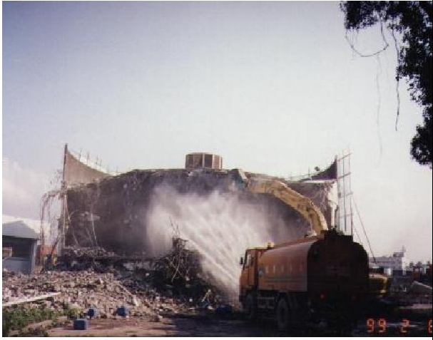
(A) 拆除作業噴灑水措施
