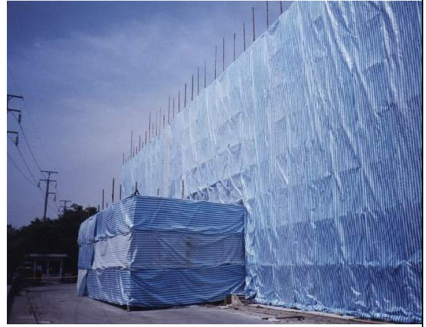
(B) 拆除作業結構體包覆防塵布
